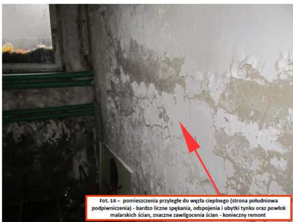
Fot. 15 – pomieszczenia przyległe do węzła ciepłego (strona południowa podpiwniczenia) - bardzo liczne spękania, odspojenia i ubytki tynku oraz powłok malarskich ścian, znaczne zawilgocenia ścian - konieczny remont
